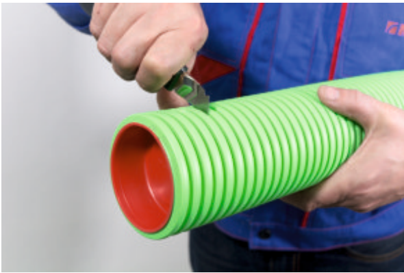
1) Raccourcir le conduit à la longueur souhaitée.
