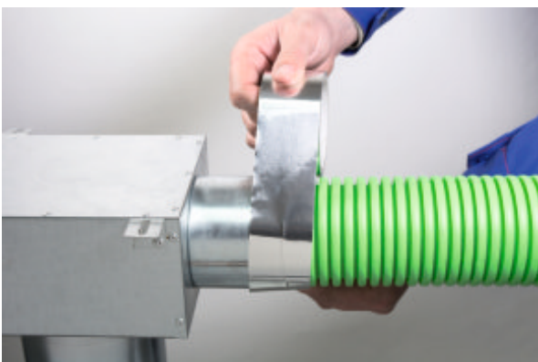
7) Bloquez le raccord avec un ruban adhésif hermétique.
